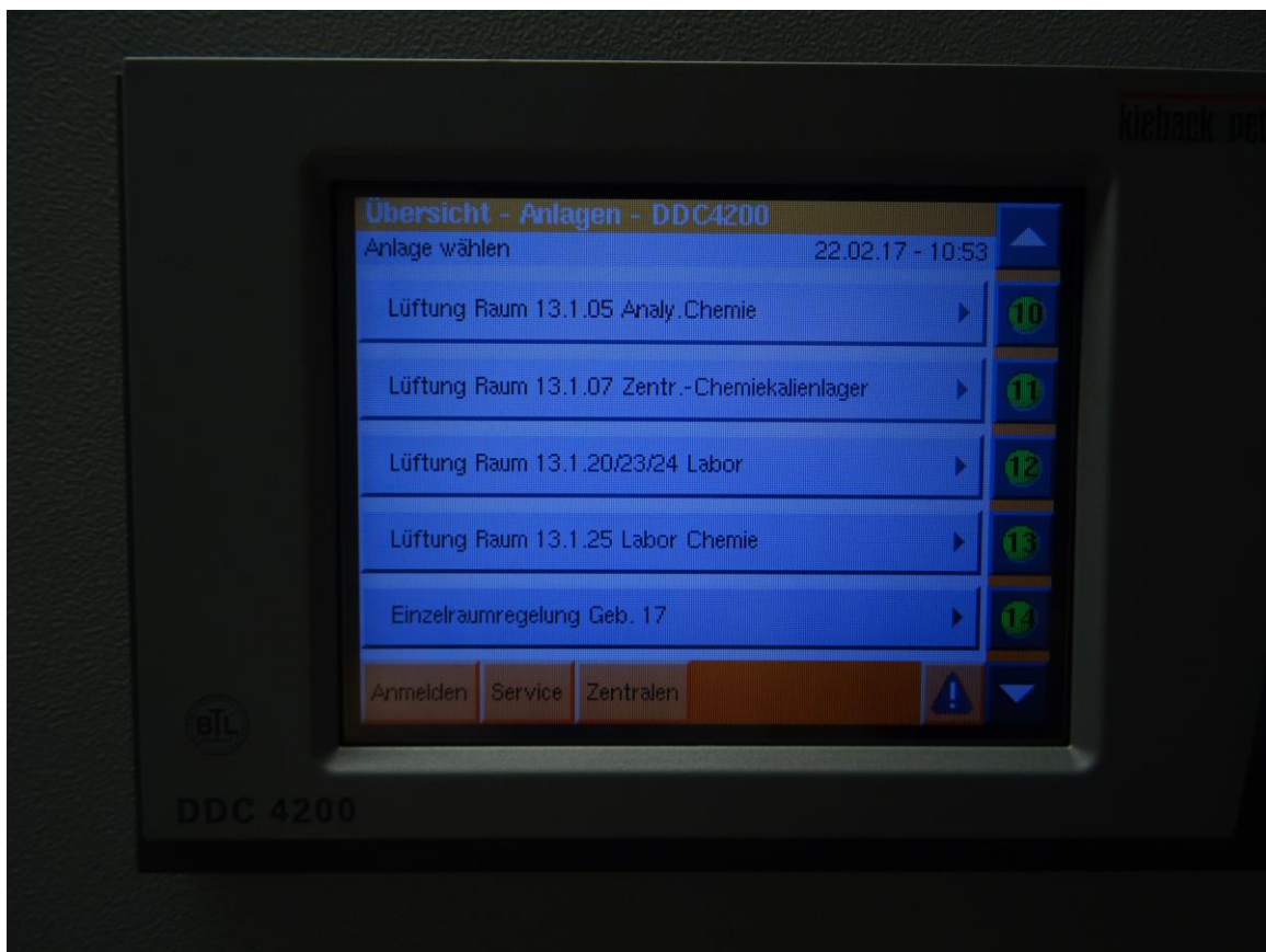
Abb. 41: Regelung Lüftung VE 13_ Verf.-Bau I (Geb. 13)
