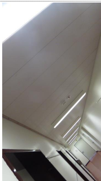
Beleuchtung überwiegend T8 Leuchtstoffröhren
